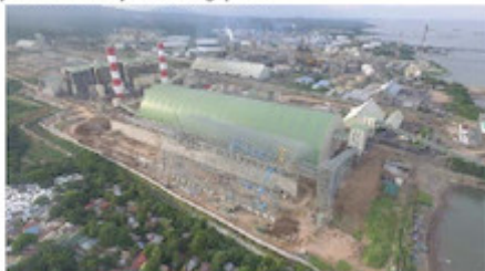
Foto 1: Derzeit läuft die Montage im Projekt Limay II (Foto SCHADE).
